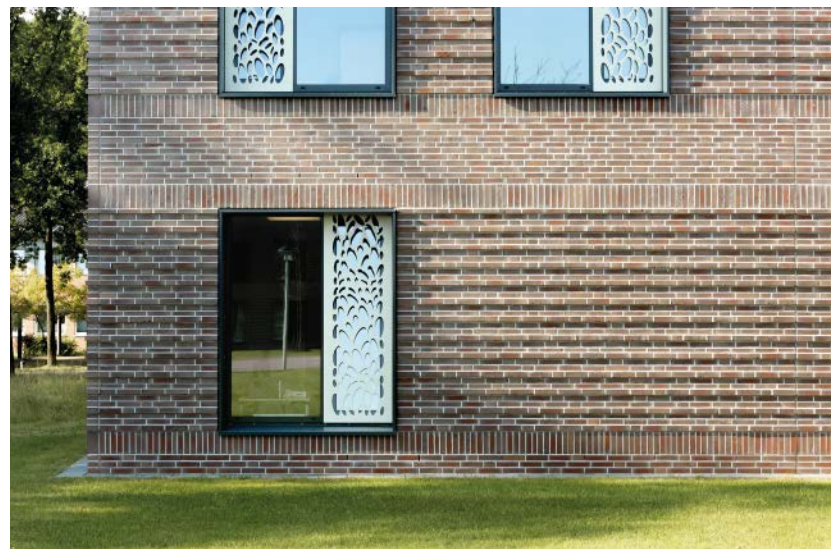
Der verklinkerte Bau wurde von PL Architekten im Pavillonstil gestaltet.
